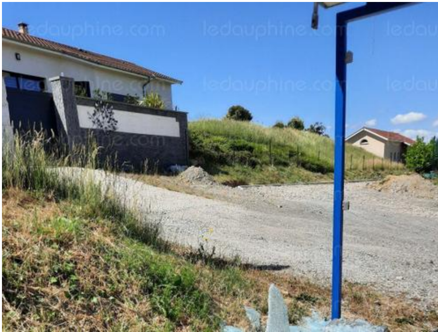
Les cinq abris bus du RD36 ont été entièrement détruits dans la nuit de samedi à dimanche 29 mai. Photo Le DL /Francoise GRANJON
