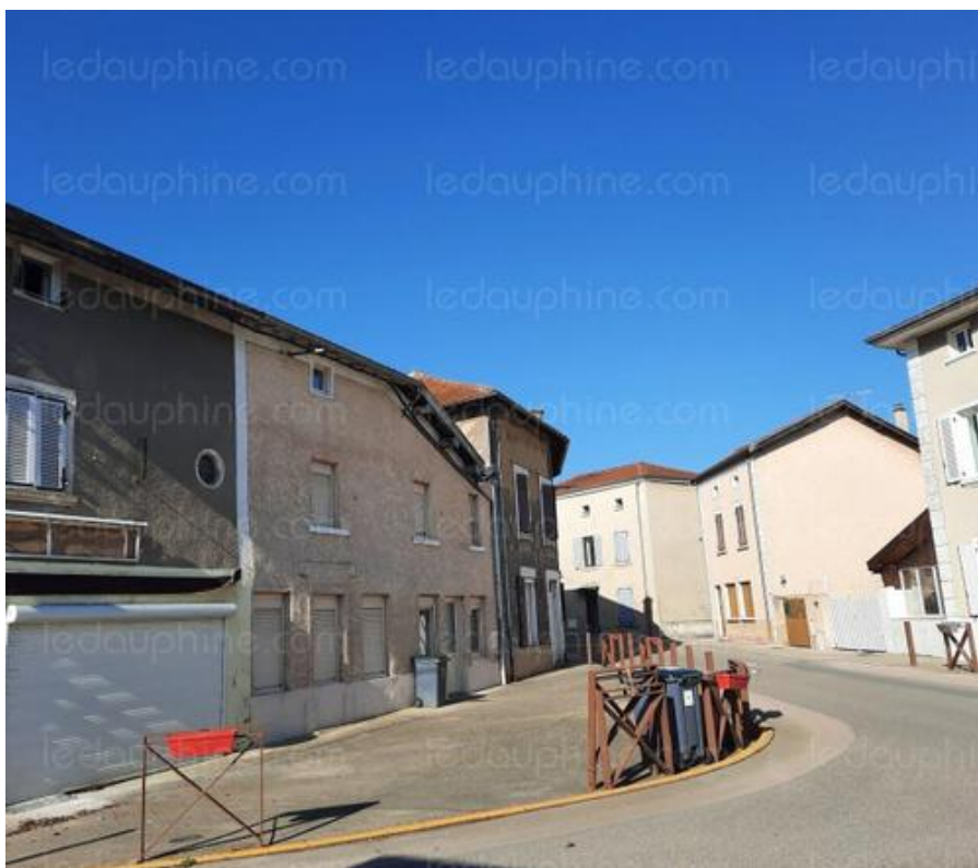
La rue des Allobroges à l'intersection de la route des Rossignols, de la rue de la mairie et de la rue du 19 mars. Photo Le DL / La rue des Allobroges à l'intersection de la route des Rossignols, de la rue de la mairie et de la rue du 19 mars. Photo Le DL /Francoise GRANJON
