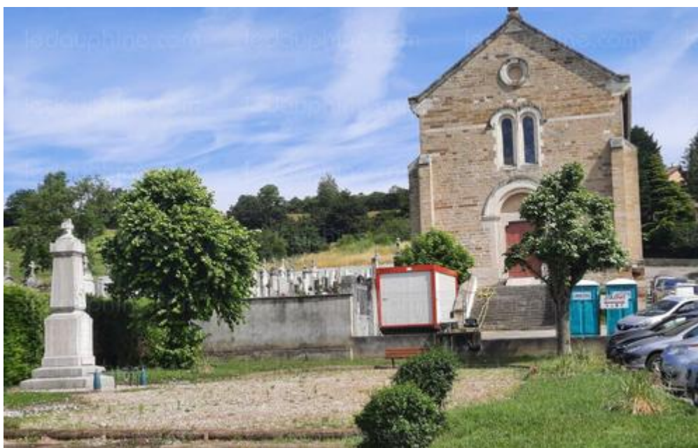
Un chantier de rénovation d'une durée de cinq mois environ est lancé. Photos Françoise GRANJON L'église Saint-Louis de Luzinay, un chantier de rénovation d'une durée de 5 mois environ.. Photo Le DL /Francoise GRANJON
