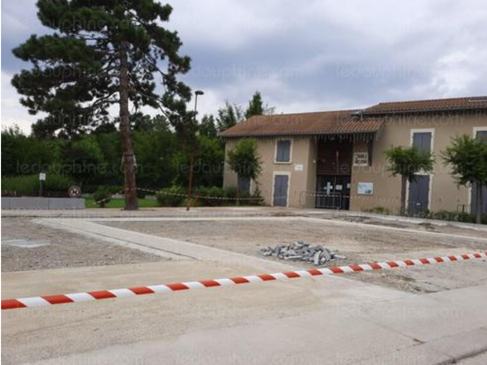
Les travaux du parking de la maison des associations sont bientôt terminés. Photo Le DL /Françoise GRANJON
