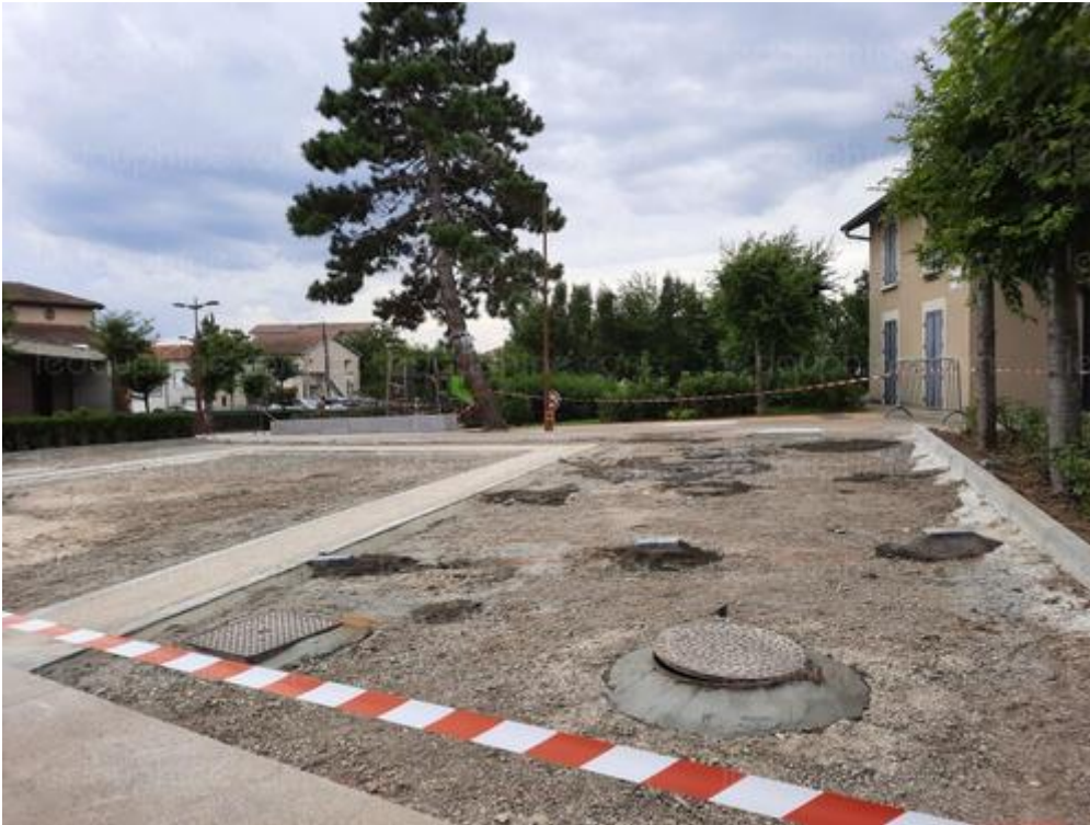
Les travaux du parking de la maison des associations. Photo Le DL /Francoise GRANJON
