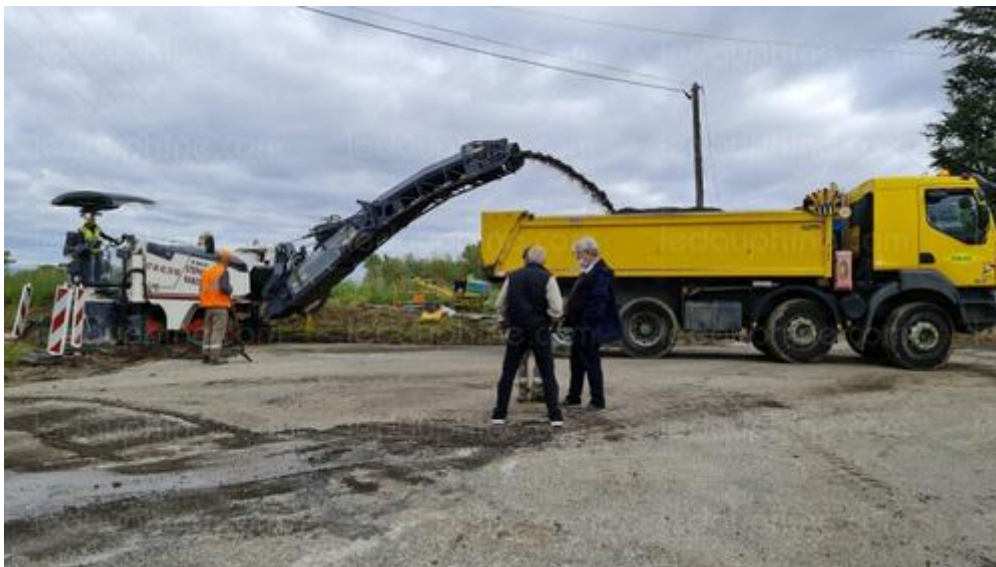
Pendant les travaux de réaménagement du carrefour. Photo Le DL /Francoise GRANJON
