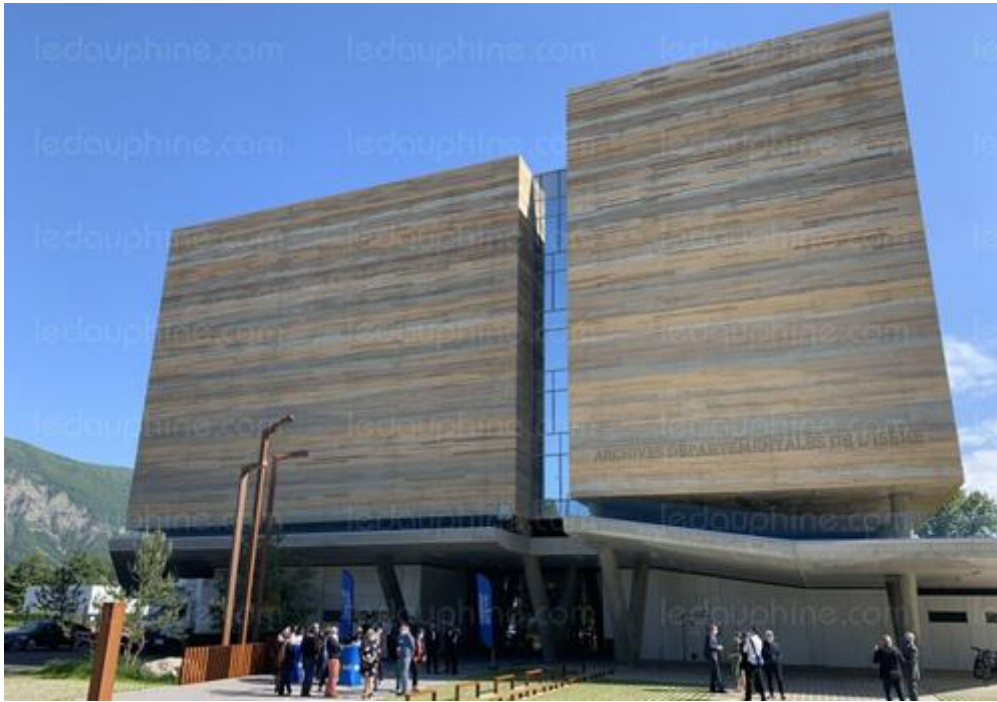
Le nouveau bâtiment des Archives départementales de l'Isère, pensé par les agences CR & ON et D3, est implanté à Saint-Martin-d'Hères. Photo Le DL/C.B.
