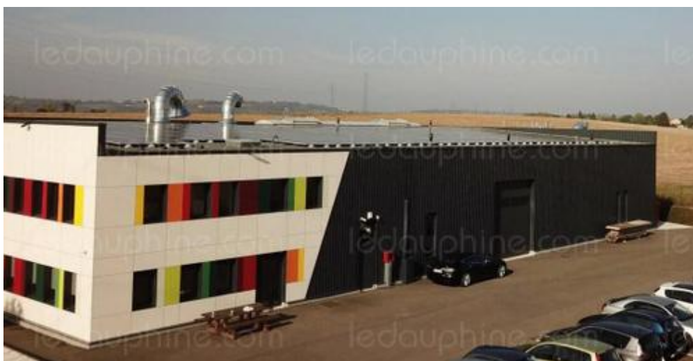
Comme ceux de la société Carré d'Ébène, toutes les toitures des entreprises du site sont équipées de panneaux, ce qui en fait la première zone d'activités photovoltaïque de France. Photo Vienne Condrieu Agglo
