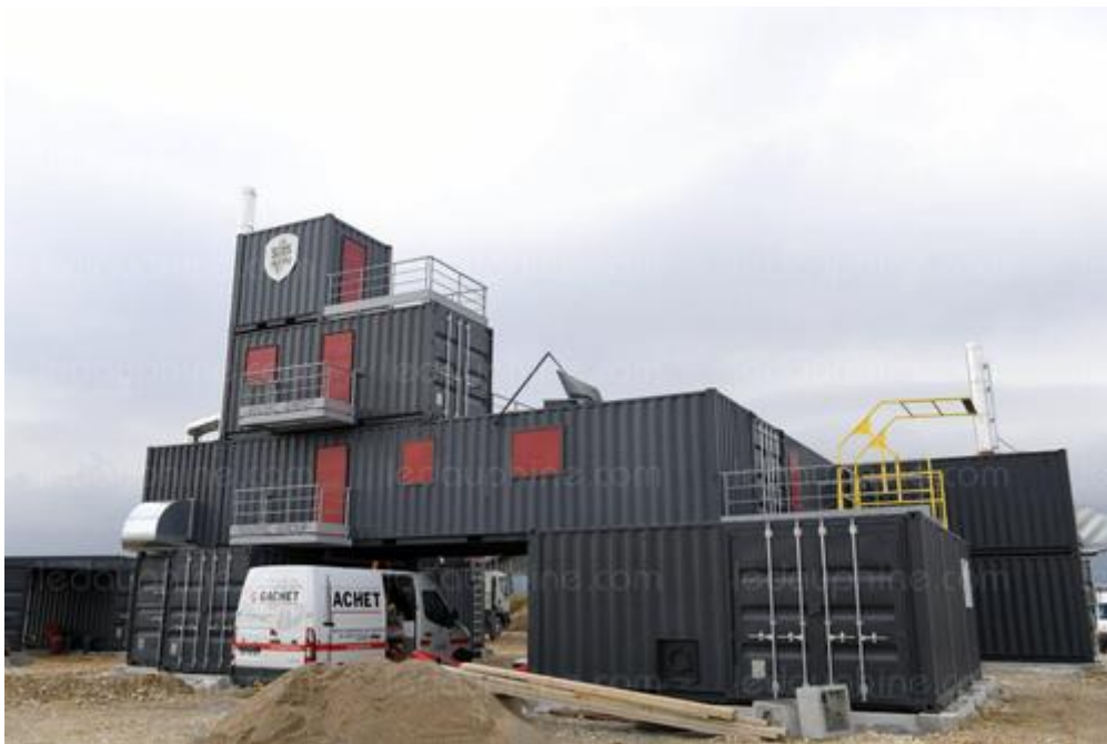
Implantée à La Côte-Saint-André, la maison à feux réels a été composée à l'aide d'une trentaine de conteneurs maritimes. Photo Le DL /Mourad ALLILI Maison à feu réelle cote saint Andre réelle Photo Le DL /Mourad ALLILI
