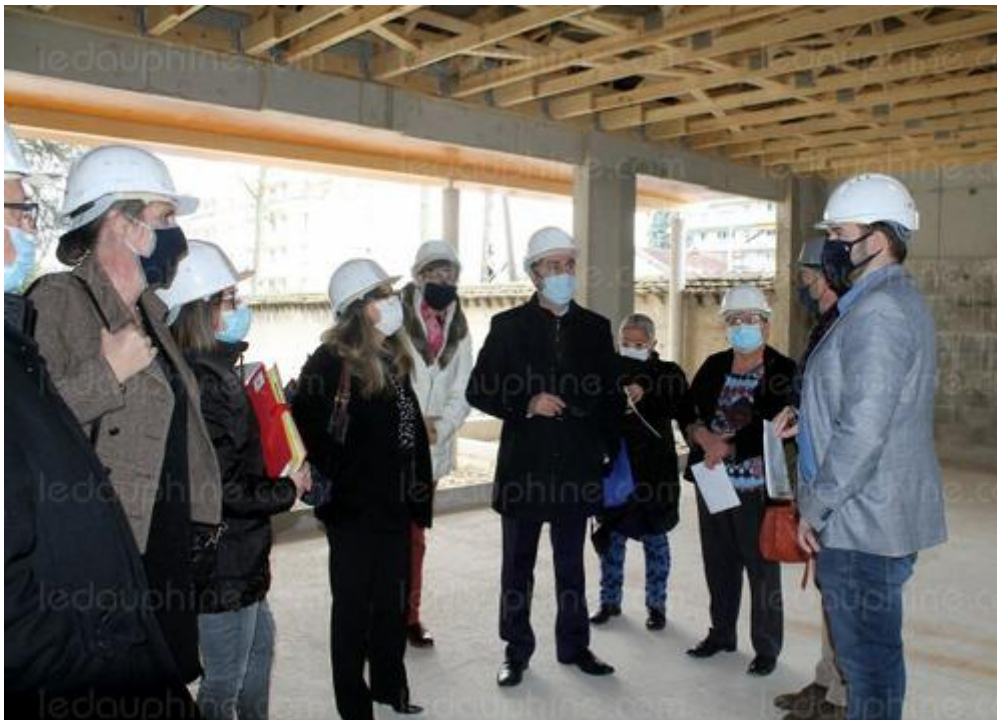
Une visite du chantier de l'extension de la crèche des Cèdres qui a permis au président de l'Agglo et à sa vice-présidente en charge de la Petite enfance de constater l'état d'avancement du bâtiment destiné à accueillir le Relais d'assistantes maternelles du secteur de l'Isle. Photo Le DL /MPJ Annick Guichard, vice-présidente déléguée à la Petite Enfance et Thierry Kovacs, président de Vienne Condrieu Agglomération ont visité le chantier du futur Relais d'assistantes maternelles, en extension de la crèche Les Cèdres, accompagnés des architectes et agents de l'agglo en charge du dossier. Photo Le DL /Marie Pierre JOACHY
