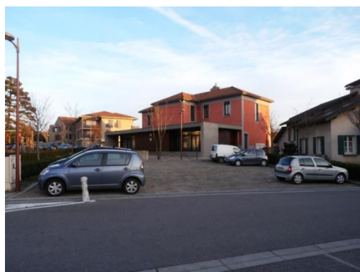
Stationnement derrière la mairie
